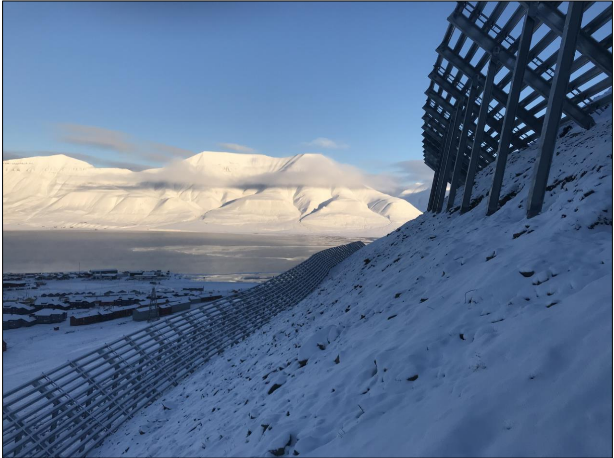
Figur 10: Eksisterende støtteforbygninger.
