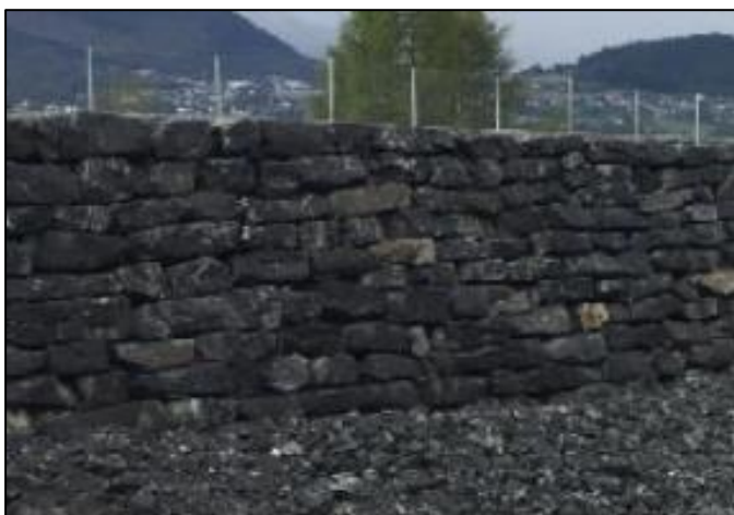
Figur 16: Eksempel: Tørrmur med lav estetisk kvalitet.
