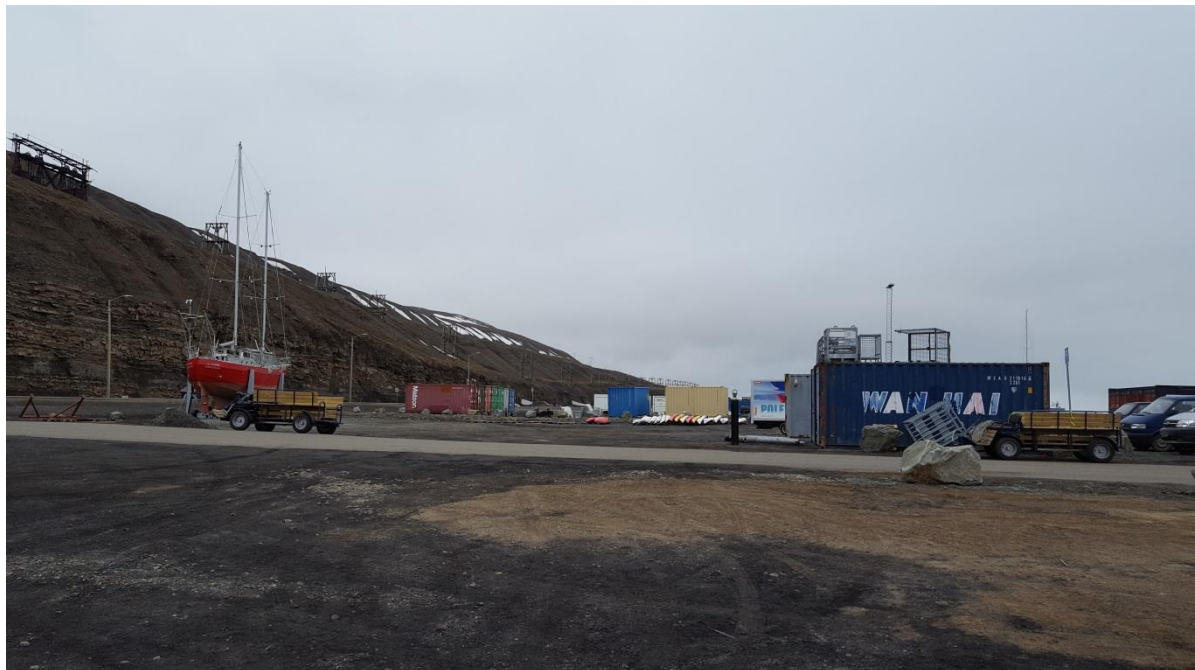
Figur 32: Areal for Havnebygg (bildet er tatt fra område for containerlagring/bussoppstilling)
