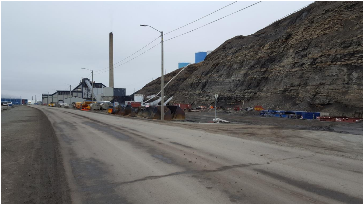
Figur 28: Bilde av energianlegget i retning mot øst (Foto: Hanne Karin Tollan)
