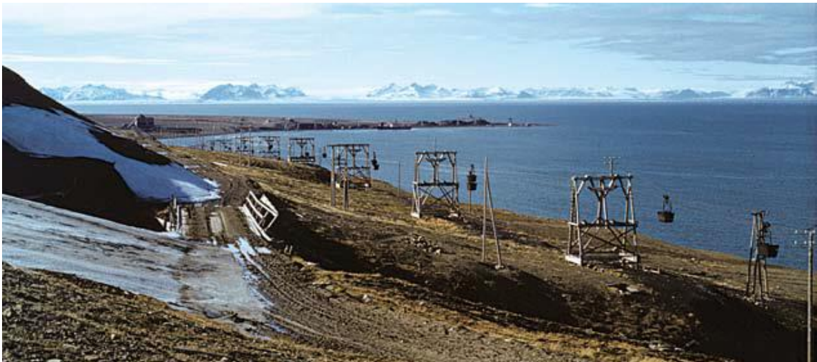
Figur 14: Burmaveien med bru
