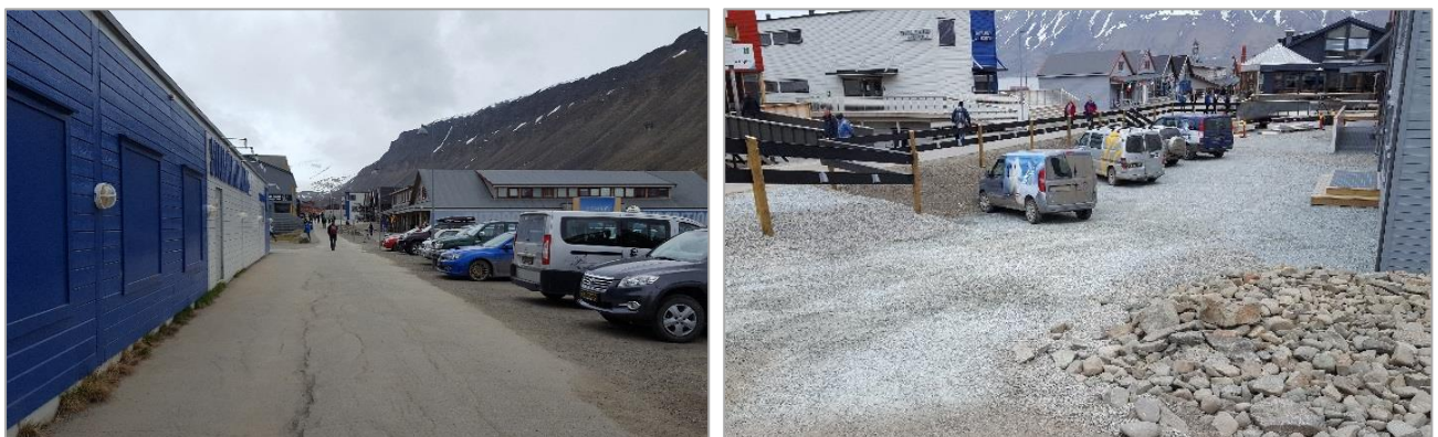
Figur 8: Lukkede fasader og manglende terrengtilpasning
