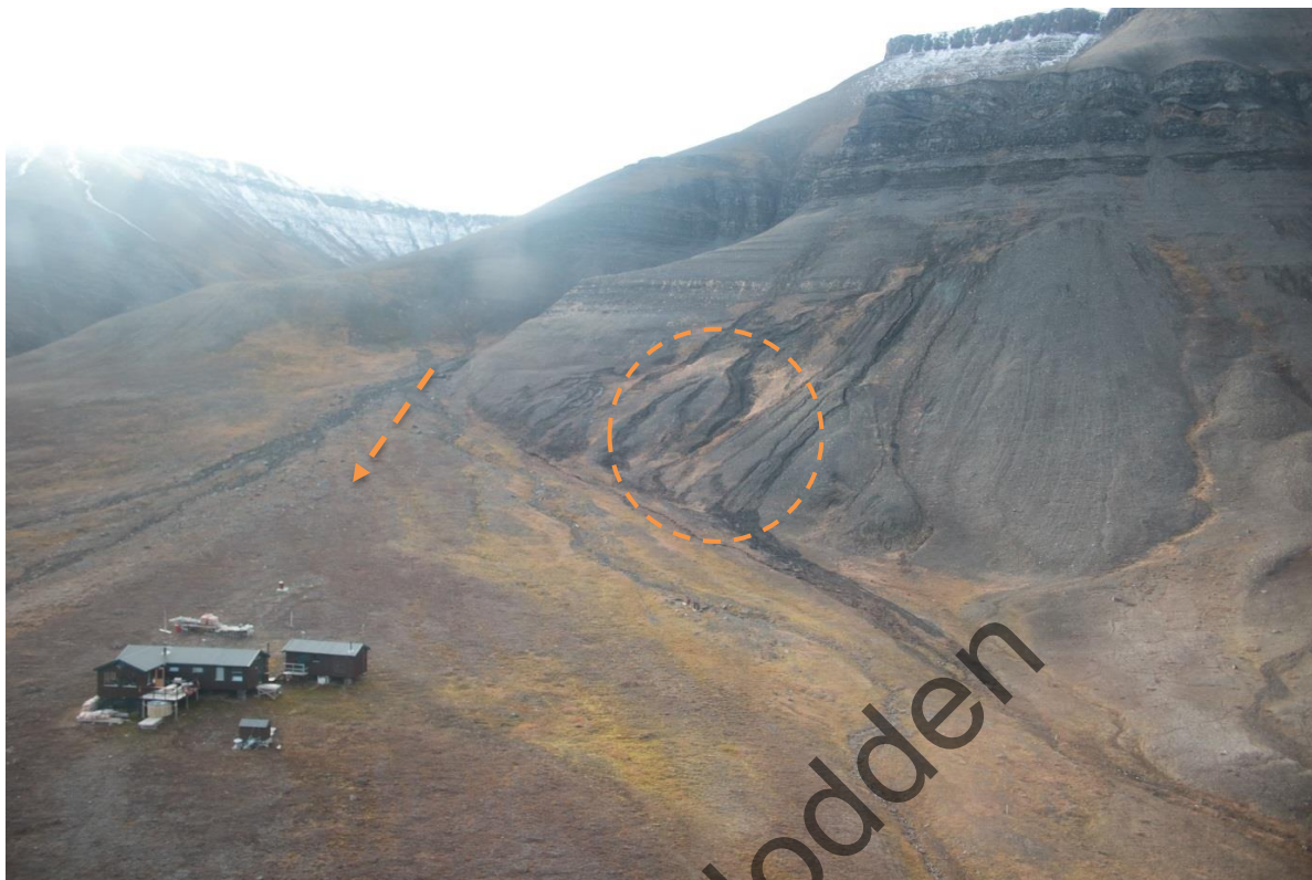
Bilde 59: Hytte plassert midt på en gammel flomavsetning. Tydelige spor etter fersk flomskredaktivitet i skråningen. Fra bekkedal vist på bildet er det registrert flere snøskredhendelser med ulik lengde på utløp. Sett mot sørøst.
