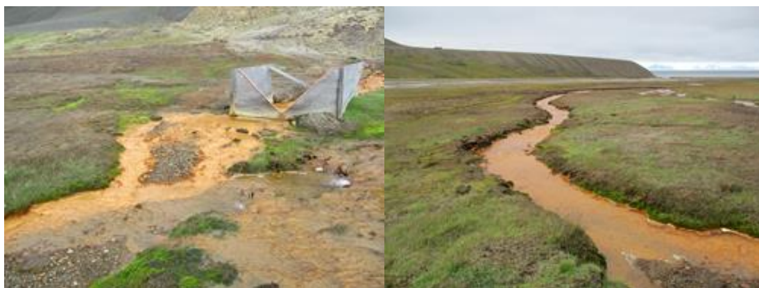
Figur 4: Gruve 3 - Tipp 3. Til venstre: Tiltaksinstallasjon for å hindre spredning av metaller. Til høyre: Bekk nedstrøms tippen. Denne løper langs Bjørnedalselva, og viser tydelig tegn på metallutfelling.
